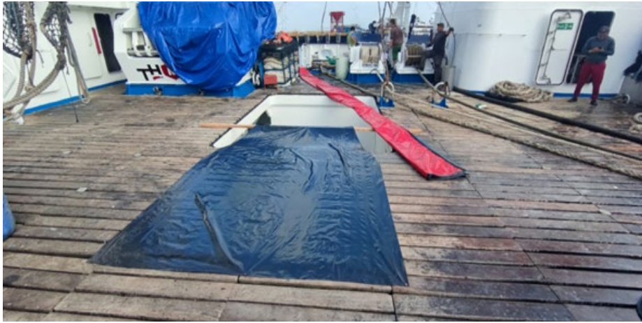
Figura 17 - Plantilla de lona del hopper y rampa en el lado de babor para examinar la viabilidad de su instalación debido al espacio limitado entre la maquinilla con una jaula de protección (extremo izquierda) y los dos chokers (a la derecha) en estribor.
